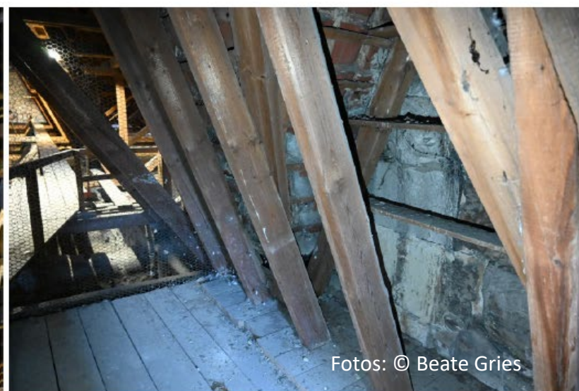
Innenhöhe begrenzt mit Kükendraht, Dachlatten zum Absitzen von Tauben, Giebelnischen mit Brettern
